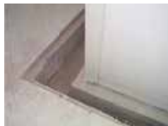
Dettaglio Scavo Excavation example
